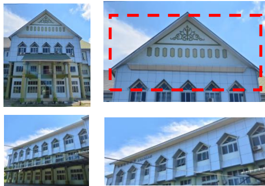
Gambar 2. Atap pada Bangunan Sumber : Penulis, 2025
