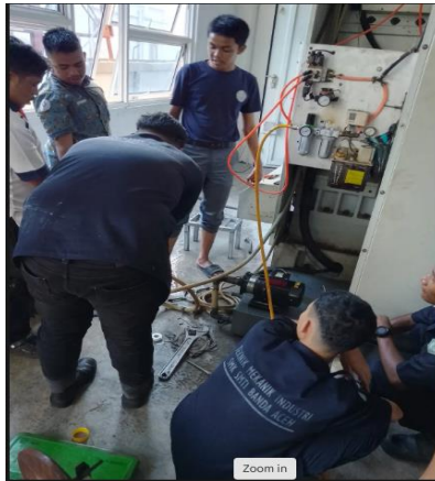
Gambar 3. Pompa Walrus TPH 2T 3K setelah pemasangan paking baru dan siap dioperasikan.
