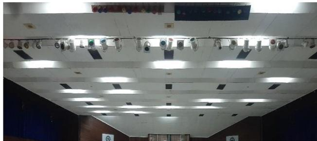
**Gambar 5** Kondisi Eksisting plafon dengan material triplek
