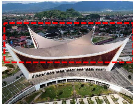
Gambar 2. Atap Bubungan pada Masjid Raya Syekh Ahmad Khatib Al-Minangkabawi (Dokumentasi Penulis, 2024)
