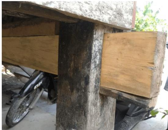
**Gambar 4.** Sambungan papan gelegar pada tiang pondasi
