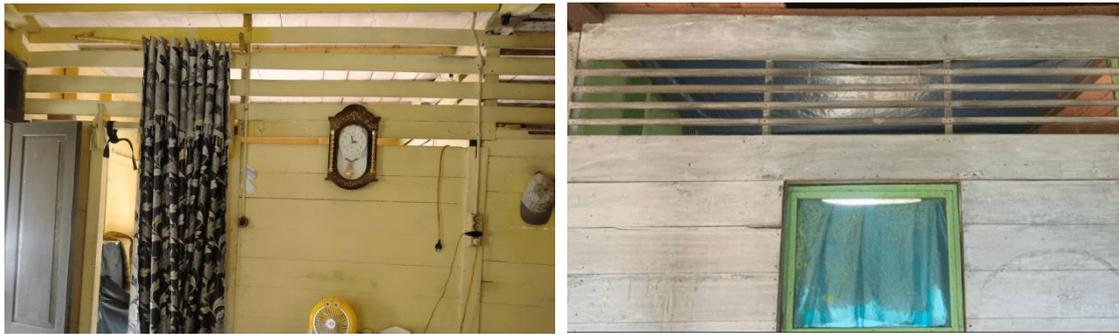
**Gambar 3.** Ventilasi pada dinding kamar
