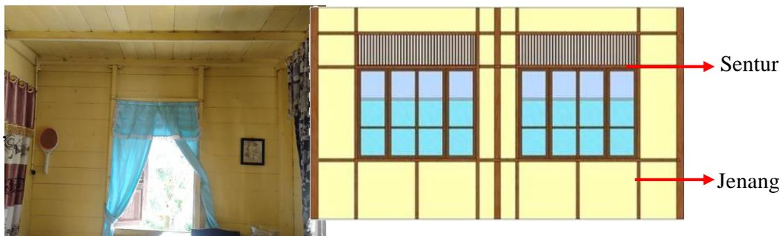
**Gambar 2.** Detail pemasangan dinding
