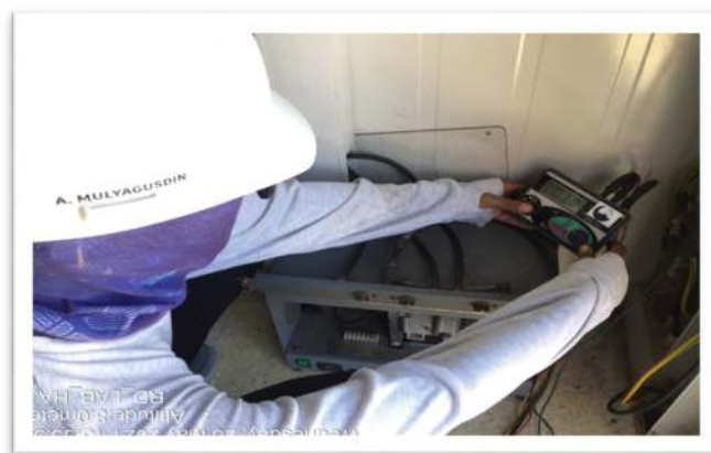
Gambar 4. Pengukuran nilai hambatan pada pembumian internal
